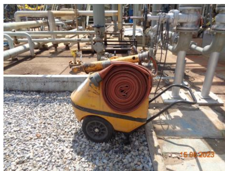
ภาพที่ 2.2-28 อุปกรณ์ดับเพลิง (ADU)
