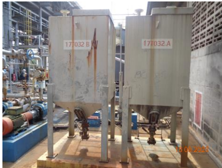
ภาพที่ 2.2-17 Slop Oil Tank เพื่อรวมคราบน้ำมัน จากบ่อกักน้ำเสีย CPI/IAF
