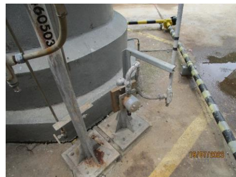
ภาพที่ 2.2-33 Hydrocarbon Gas Detector
