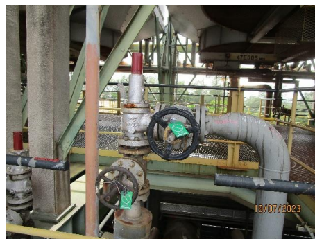
ภาพที่ 2.2-42 วาล์วระบายความดัน (Pressure Relief Valve)
