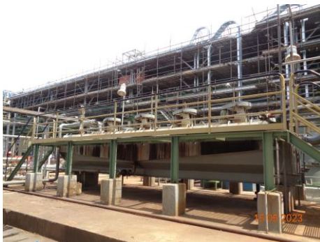
ภาพที่ 2.2-7 ป่อพักน้ำเสีย IAF หน่วย ADU
