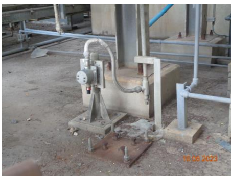
ภาพที่ 2.2-32 H 2 S Gas Detector
